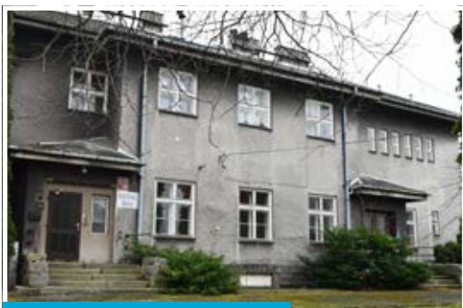
Budova bývalé mateřské školy před zahájením stavebních prací v srpnu 2020.
